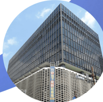
本社 ニュー新橋ビルに移転
